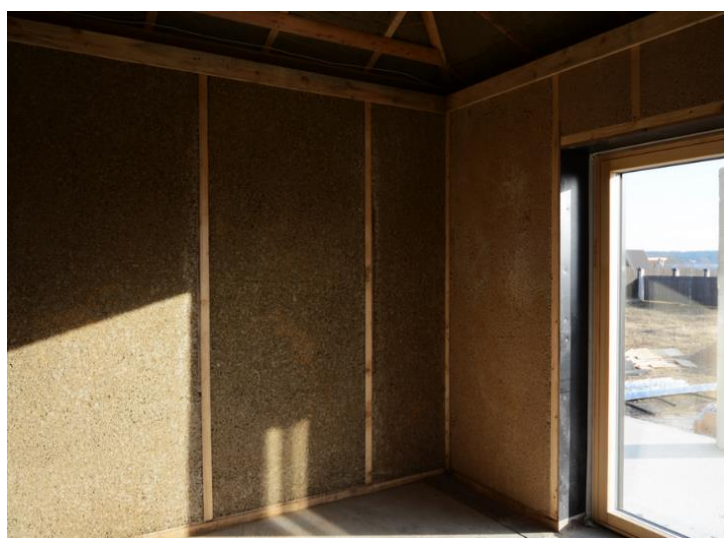
Att. 2 Rūpnīcā ražoti gatavi sienas paneļi
