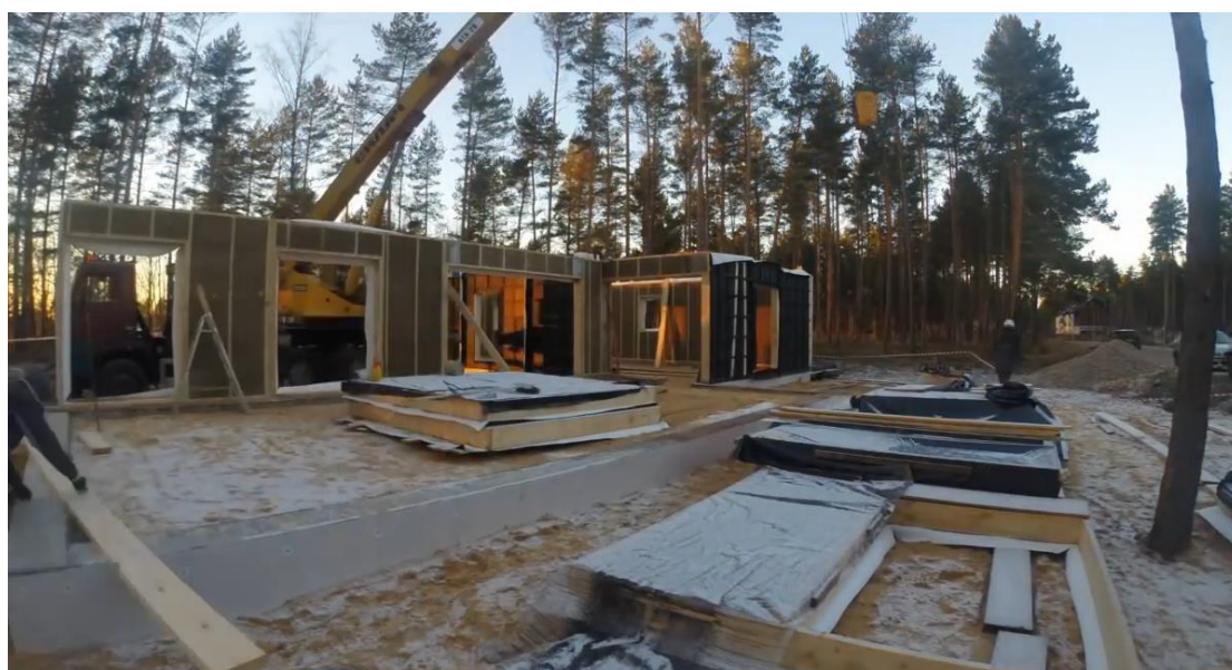
Att. 3 180 m 2 kaņepju-kaļķa paneļu ēkas montāža Ādažos
