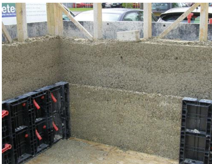
Att. 1 Iestrāde uz vietas objektā ar veidņu palīdzību
