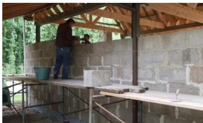
Att. 3 Kaņepju-kaļķa bloku mūrēšana
