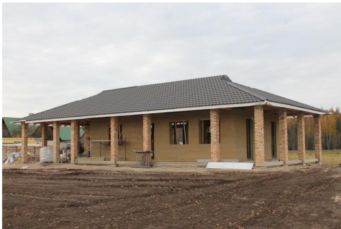
Att. 2 SIA "Hemp Eco System Latvia" celtā ēka Ikšķiles novadā
